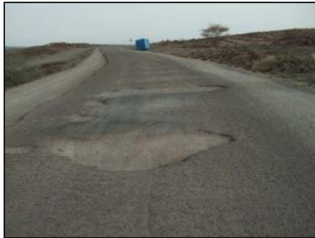
Figure 49. Transafricaine 6. Section Djiboutienne – Vue générale du tronçon Gallafi - Dikhil
