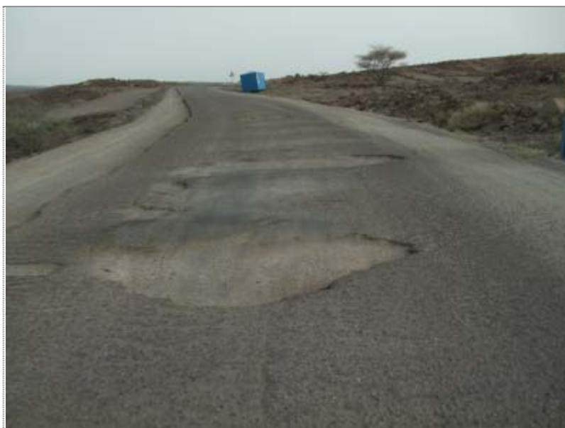
Figure 87. Vue sur la Transafricaine 6 – Section Djiboutienne (PK 81 – Dikhil)
