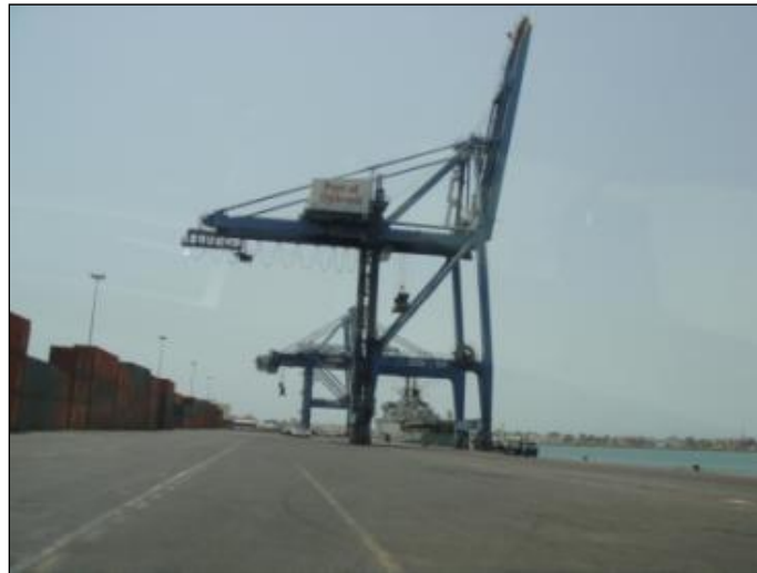
Figure 19. Vue générale du nouveau terminal conteneur de Doraleh
