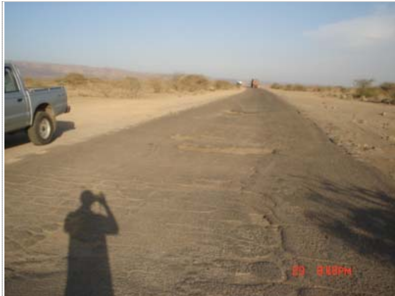
Figure 84. Vue sur la Transafricaine 6 – Section Djiboutienne (PK 200 – Dikhil)
